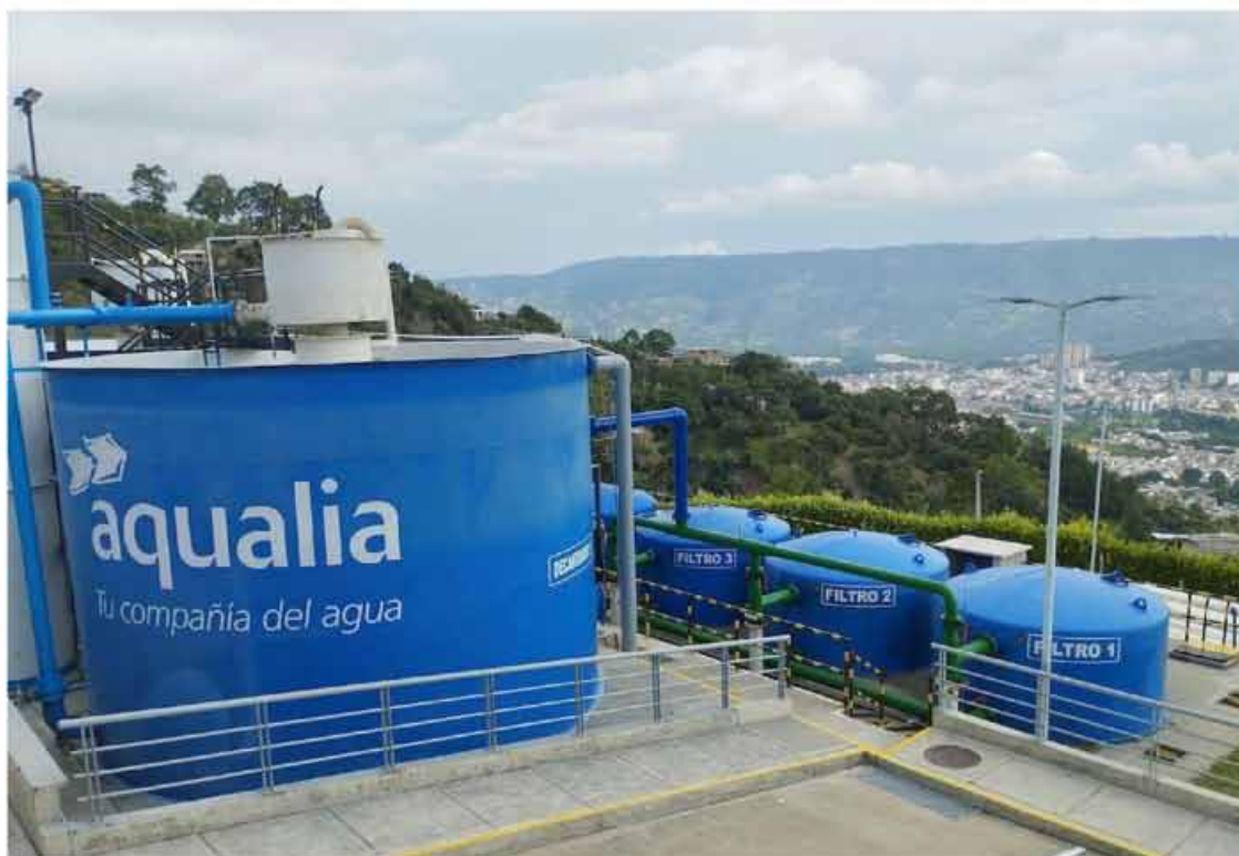
Según Aqualia, estas obras permitirán duplicar la capacidad de las estaciones de bombeo.
