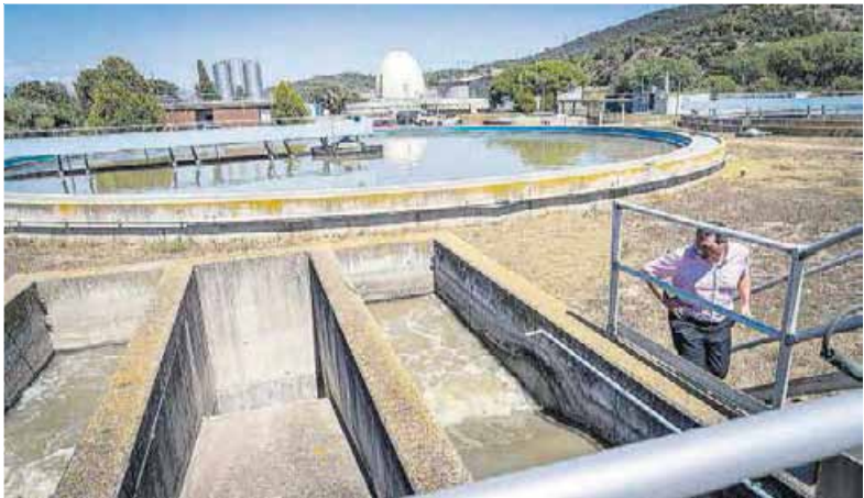
Imagen de la depuradora de La Llagosta.
