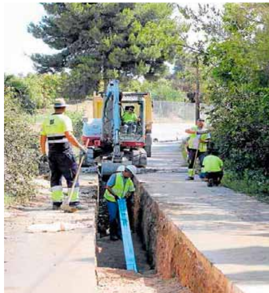
Obras de la tubería para agua regenerada de Alhaurín de la Torre. J. R. C.
