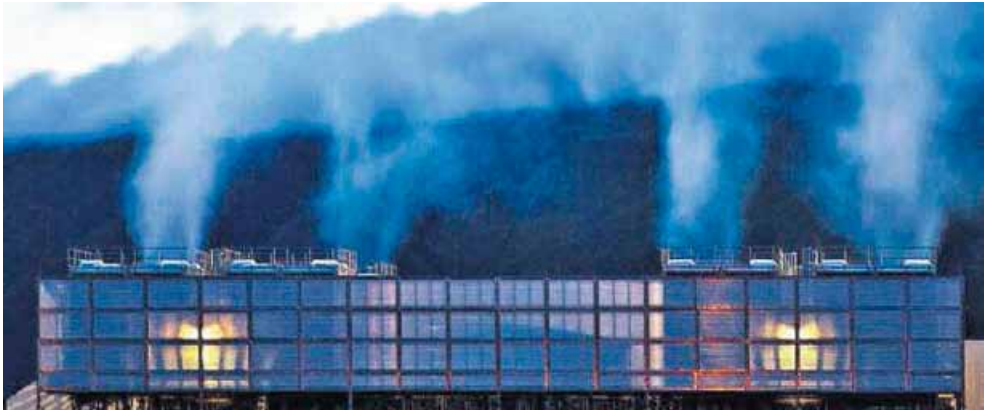
Centro de datos de Google, junto al río Columbia, en EEUU. / WAREWATER
