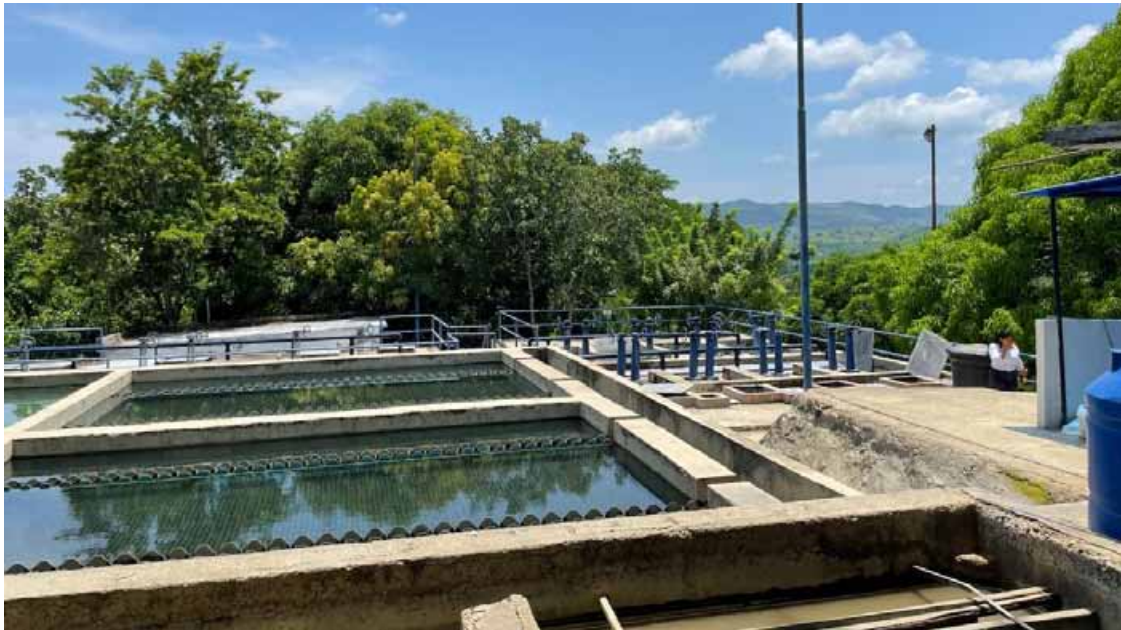
Acueducto en el municipio de Luruaco
