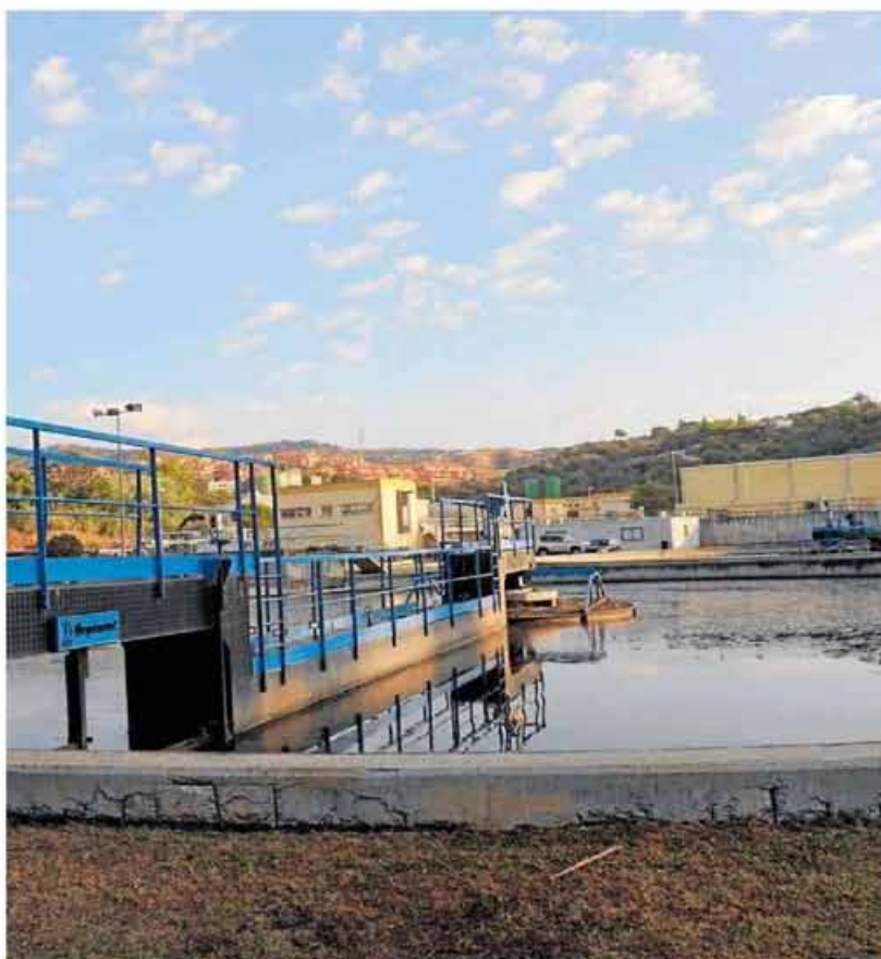
Depuradora de La Vóvora, en Marbella, una de las pioneras del terciario en la Costa. JOSELE
