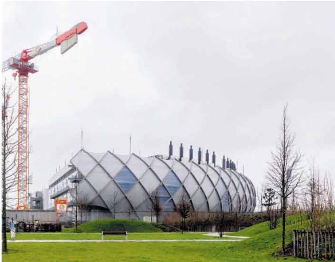
Aspecto en febrero de 2023 de la construcción del mayor centro de datos de Francia, situado en París.
