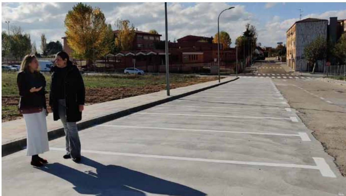
El nuevo aparcamiento para los vecinos de Santa Marta de Tormes
